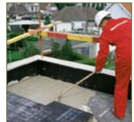
Solution collée en plein à l'aide de FIX UP
