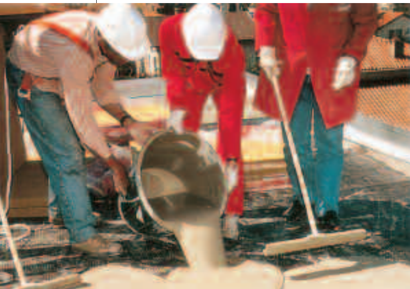
... le liant est répandu sur le support...
